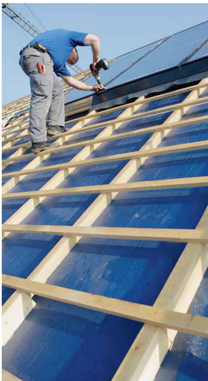
Eine Solarstromanlage wird montiert. Ob ein Hausdach für diese Art der Energiegewinnung geeignet ist, zeigt der neue Kataster. Bt/a
